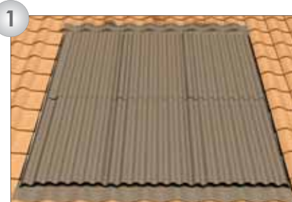
1) RIMOZIONE DELLA CARPENTERIA E POSIZIONAMENTO DELLE CONVERSE NELLO SPAZIO NECESSARIO ALL'INSTALLAZIONE.
