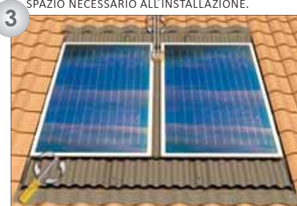
3) Posizionamento e fissaggio dei collettori sulla struttura e montaggio della raccorderia.
